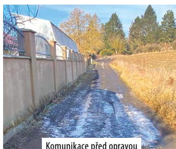
Komunikace před opravou
