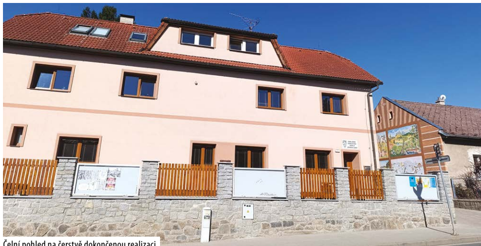
Čelní pohled na čerstvě dokončenou realizaci
