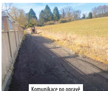
Komunikace po opravě
