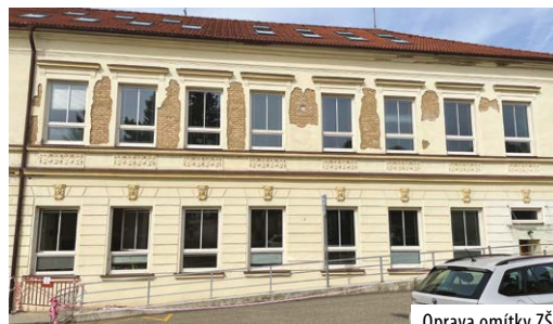
Oprava omítky ZŠ
