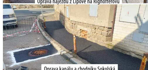
Oprava kanálu a chodníku Sokolská
