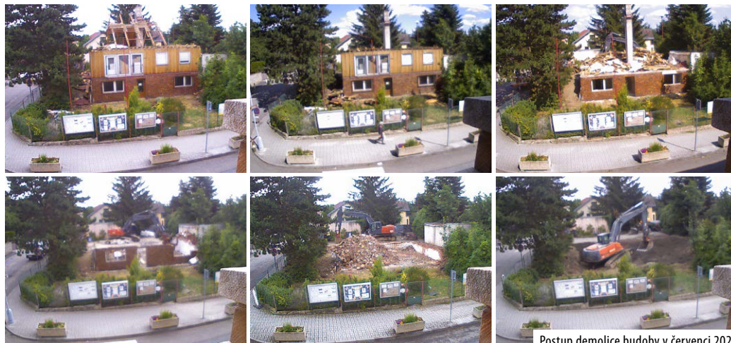
Postup demolice budovy v červenci 2024
