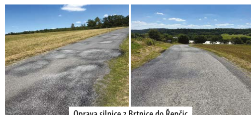
Oprava silnice z Brtnice do Řepčic
