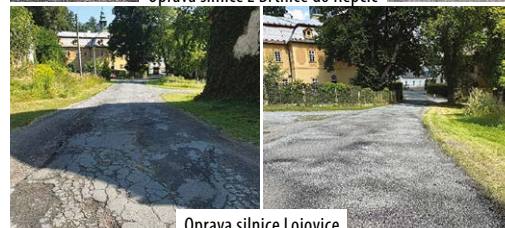
Oprava silnice Lojovice
