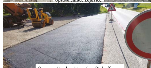
Oprava nájezdu z Lipové na Righofferovu
