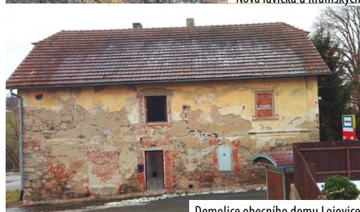
Demolice obecního domu Lojovice
