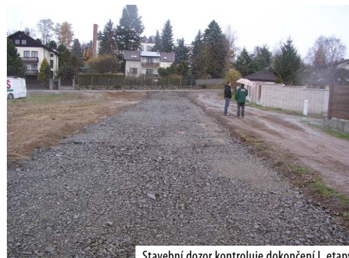
Stavební dozor kontroluje dokončení I. etapy
