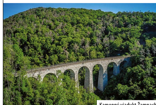
Kamenný viadukt Žampach
