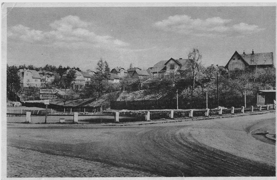
Začneme proti proudu času – tento pohled z roku 1954 od staré vrátnice pivovaru možná ještě leckomu z pamětníků vybaví vzpomínku, jak to zde tehdy vypadalo...
