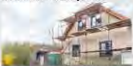
Rozestavěný RD 4+1, Brtnice, Praha východ
