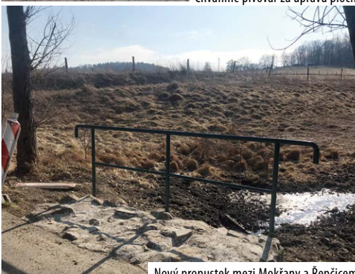
Nový propustek mezi Mokřany a Řepčicemi
