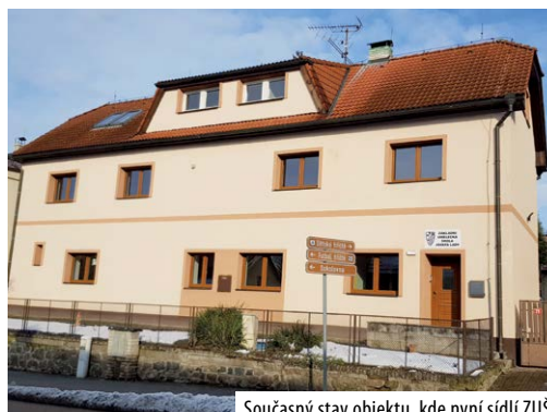
Současný stav objektu, kde nyní sídlí ZUŠ.
