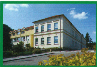
Stará budova ZŠ Velké Popovice, s přístavbami
