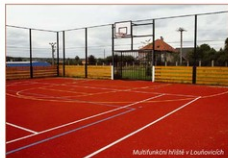
Multifunkční hřiště v Loučovicích
