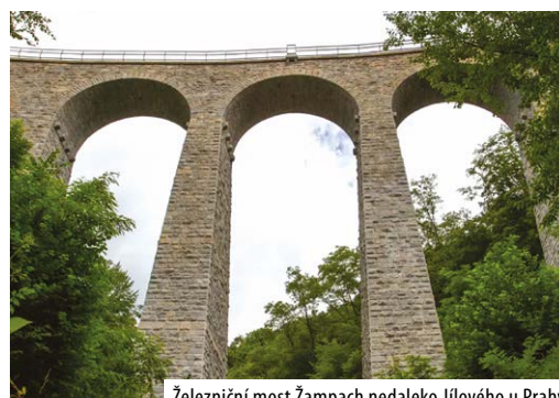
Železniční most Žampach nedaleko Jílového u Prahy
