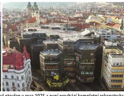
OD Kotva byl otevřen v roce 1975 a nyní prochází kompletní rekonstrukcí.
