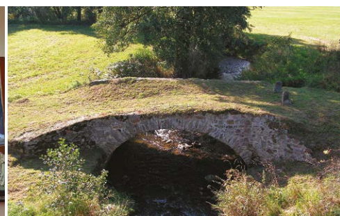
Památný klenutý kamenný most přes Borovský potok
