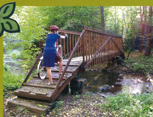
mostek přes Mnichovku
