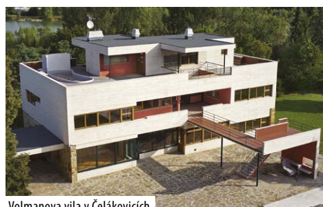
Volmanova vila v Čelákovících
