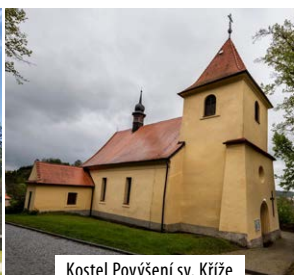
Kostel Povýšení sv. Kříže
