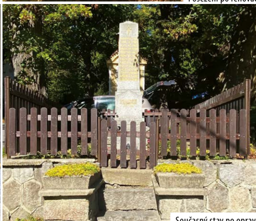
Současný stav po opravě
