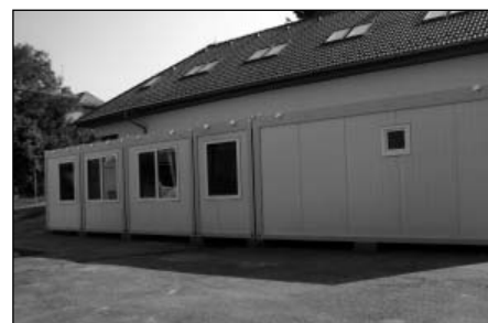
Foto 11: Jídlna přístavba – rozšíření kapacity
