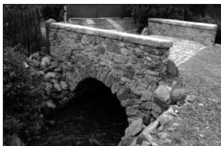
Foto 13: Mostek Mokřany – oprava historické památky
