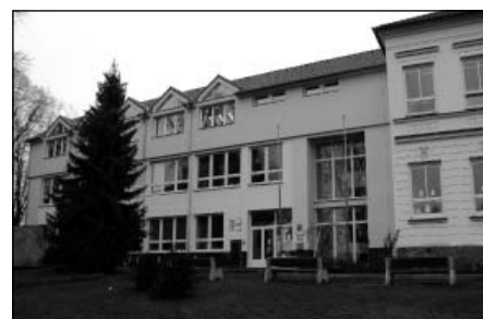
Foto 6: ZŠ nástavba – rozšíření kapacity
