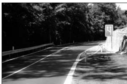
Foto 5: Rekonstrukce a rozšíření silnice 107-II
