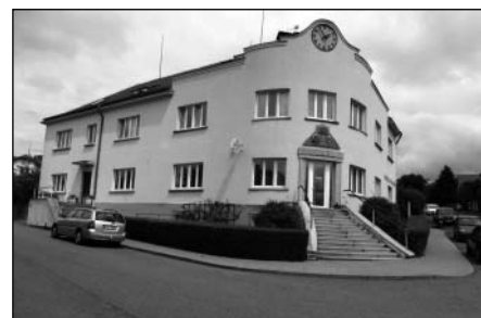
Foto 14: Dům lékařů – nová okna
