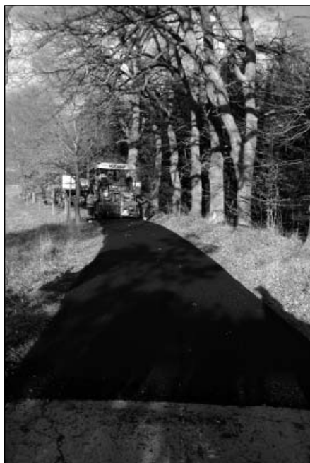
Foto 16: Rekonstrukce komunikací 2013 – Krámský
