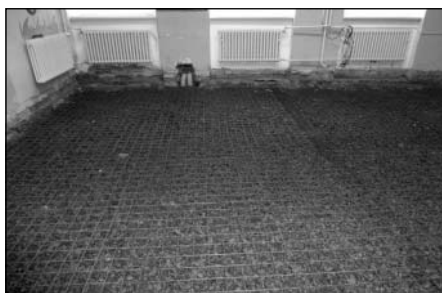
Foto 12: ZŠ – rekonstrukce podlah ve staré budově
