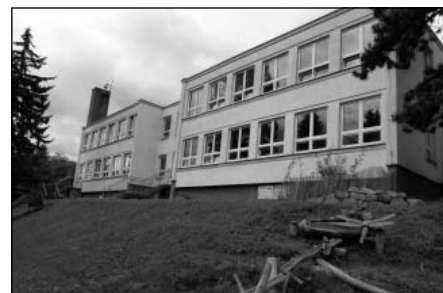
Foto 3: Nová okna MŠ
