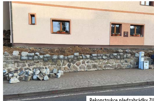
Rekonstrukce předzahrádky ZUŠ
