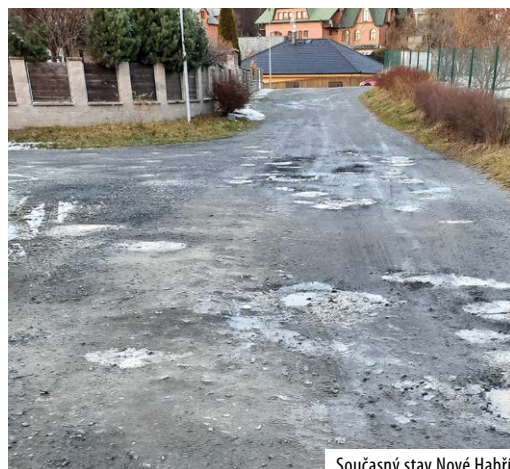
Současný stav Nové Habří
