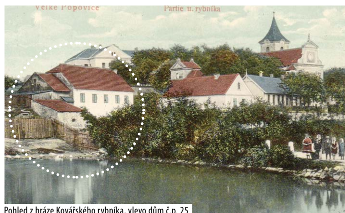
Pohled z hráze Kovářského rybníka, vlevo dům č.p. 25
