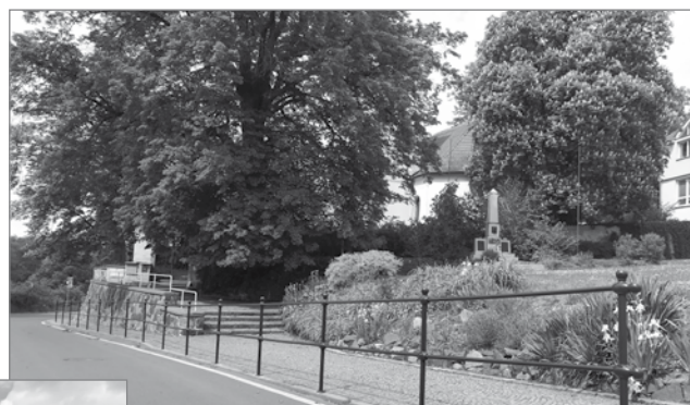
Nové zábradlí před základní školou
